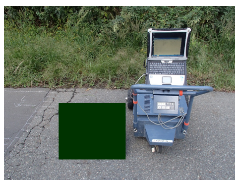
写真 チャープ式レーダ装置及び測定状況
