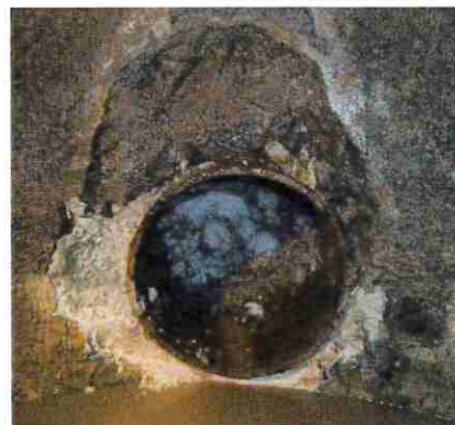
先導体リターン状況
