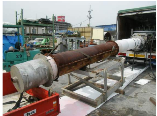
写真19 \phi 450のライニング状況
