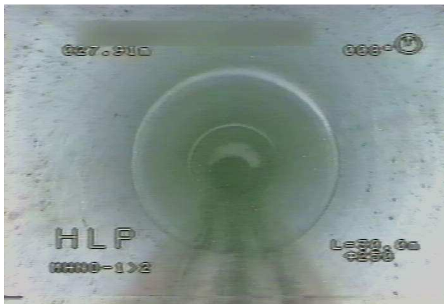
写真 2 2 ホースライニング工法施工管
