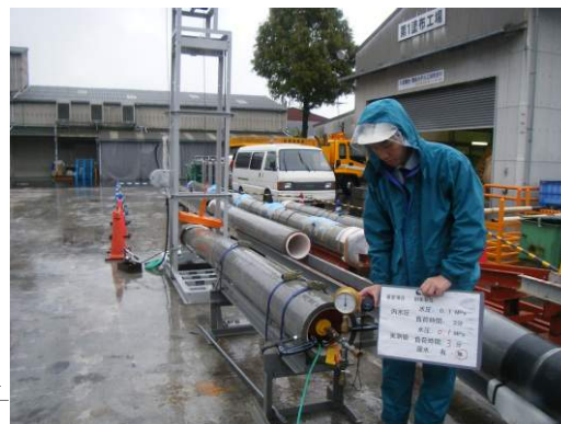
写真 11 水圧試験状況
