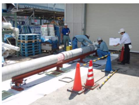
写真4 ライニング状況
