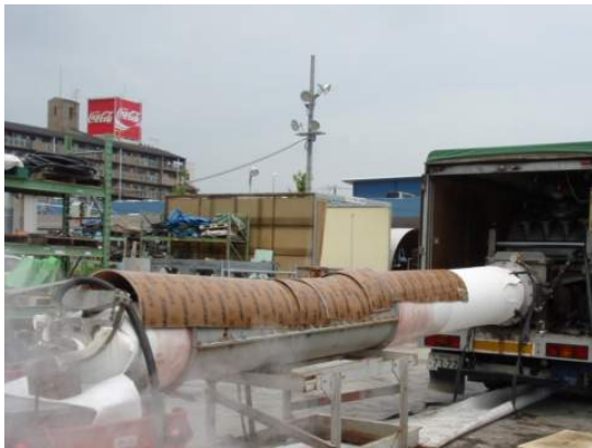
写真18 \phi 600のライニング状況
