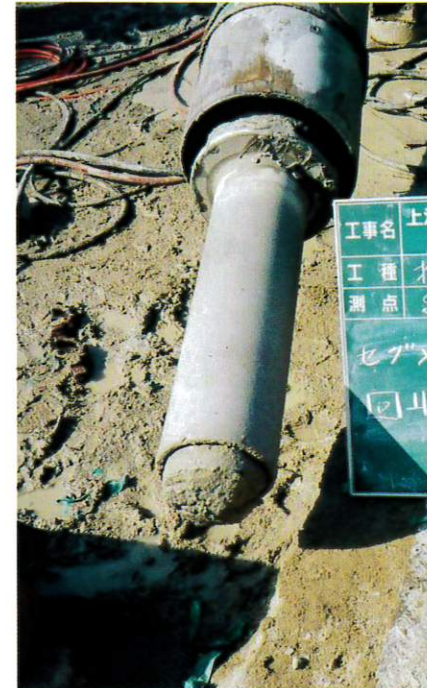
コア回収状況
