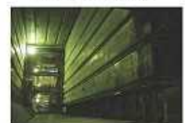
内部掘削完了
