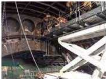
施工状況(ユニバーサル継合使用)
