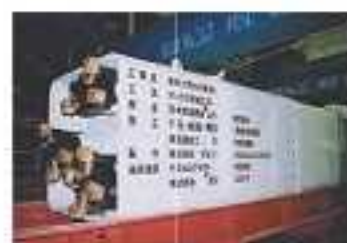
多輪ボックス重直機据付状況
