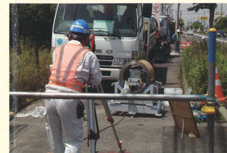
測量機を使用して出発人孔芯とBC点を結ぶ方位に外殻管の向きを設定して初期方位の計測を行います。
