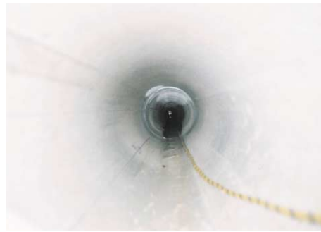
施工後のヒューム管内 (直線に修正)
