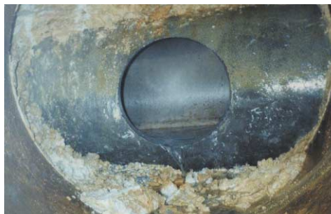
ヒューム管削孔状況
