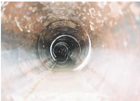
施工前の陶管内 (蛇行)
