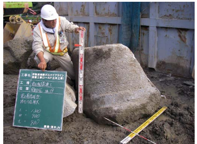
発進立坑掘削時に出土した旧護岸石積(巨礫) 巨礫径(1300mm×900mm×900mm)
