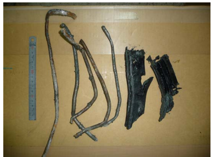
排出した金属片。推進管のカラー及び鉄筋
