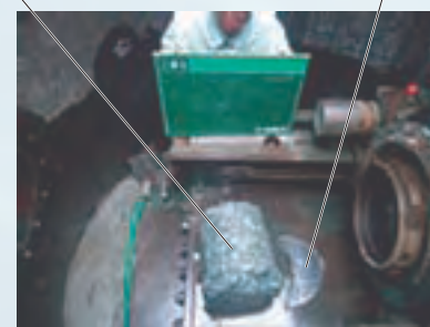
既設マンホール切断
