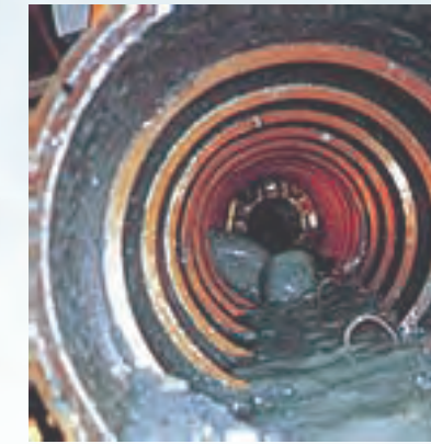
■ 排土状況 (ケーシングロッド内)
