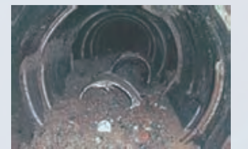
既設管・掘削土排土
