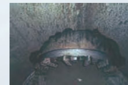
既設マンホール到達
