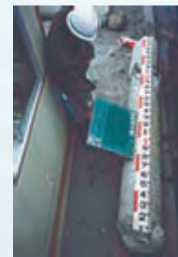
橋脚基礎切断
