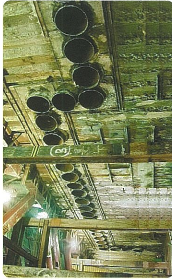
工事件名 首都高速SJ34工区トンネル工事 施工者 間・五洋・本間JV 施工場所 東京都 渋谷区 施工内容 φ812.8 100m×32本 (3,200m)
