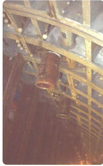
工事件名 首都高速SJ34工区トンネル工事 施工者 間・五洋・本間JV 施工場所 東京都 渋谷区 施工内容 先行切梁φ355 11m×35本
