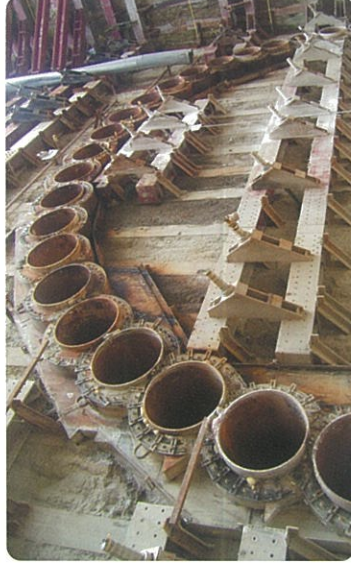
工事件名 北幹・高丘T(南)他2工事 施工者 戸田・フジタ・アイサワ・藤森JV 施工場所 長野県 中野市 施工内容 φ812.8 110m×22本 (2,420m)
