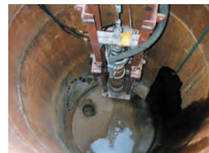
ダウンザホールハンマーによる岩盤掘削
