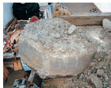
●砂岩切削状況
