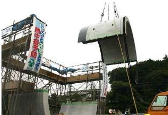
写真3 上部材吊り上げ
