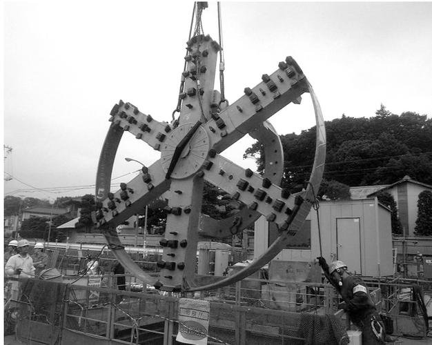
写真-4.6 掘進機の現地組立状況
