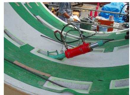
図-4.6 PC鋼材の挿入・緊張要領
