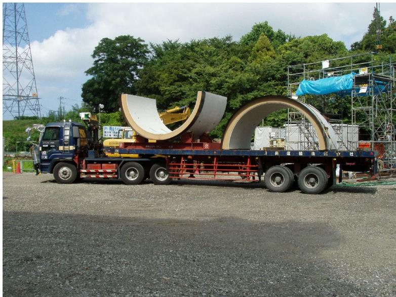
写真-4.1 分割型PC推進管運搬状況（トレーラーの場合）
