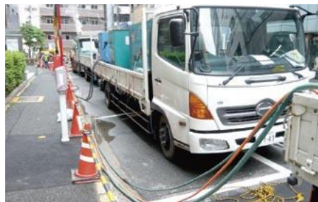
地上配管・配線
