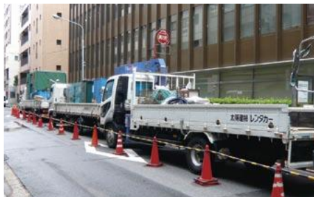
資材運搬車（3台目）
