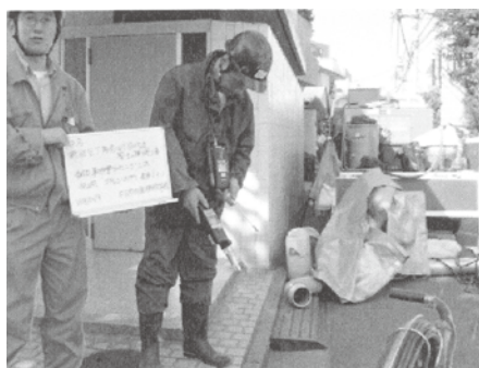
施工前 境界線
