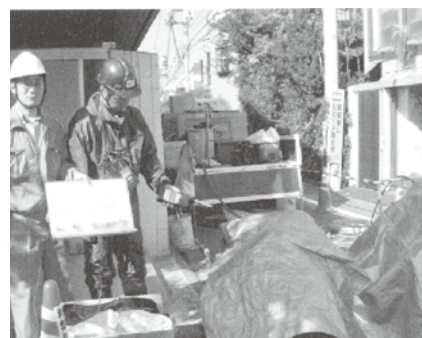
施工後 境界線
